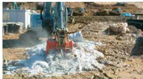
③ ボンファイバー混合状況
