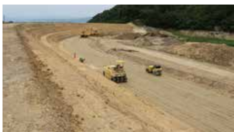
④ 転圧状況
