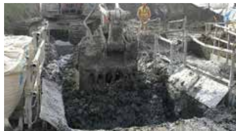
③ 改良状況
