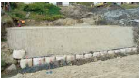
⑤ 橋台部完了
