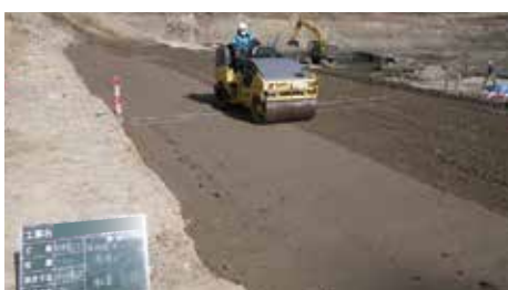
⑤ 転圧状況
