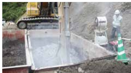
③ 改良状況
