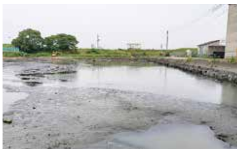
浄水場・排水機場の発生泥土
