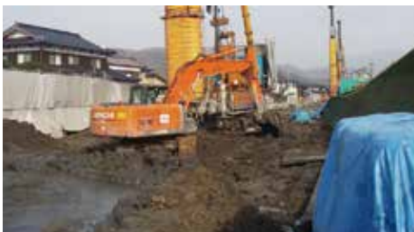
② CDM 泥土排出状況
