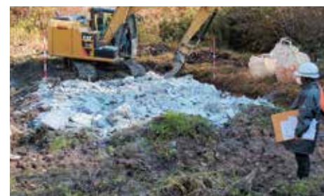
原位置攪拌状況
