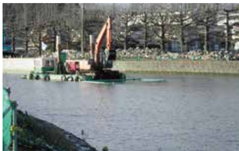
河川・港湾浚渫土
