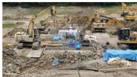
③ 改良状況
