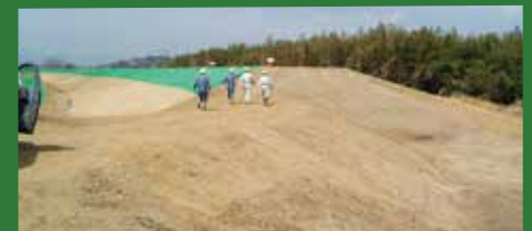
③ 築堤完成
