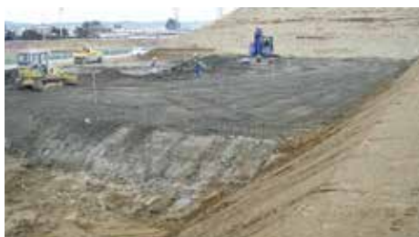
⑤ 改良土敷均し・締固め
