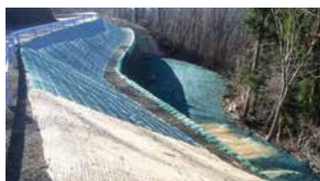
⑥ 改良土再利用状況全景
