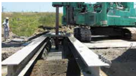
① SMW 排泥土発生
