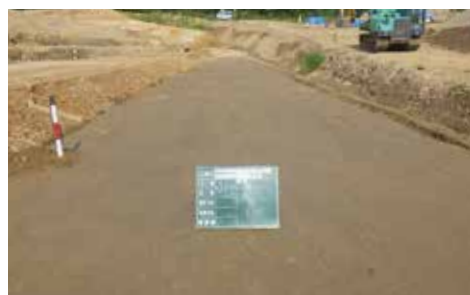
⑥ 転圧完了
