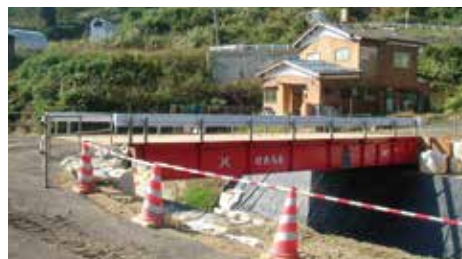
⑥ 仮橋完成
