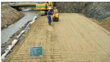
④ 橋台部ボンテラン改良土転圧状況
