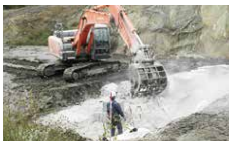
原位置攪拌状況
