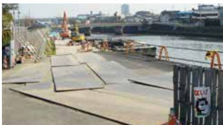
① 現場全景
