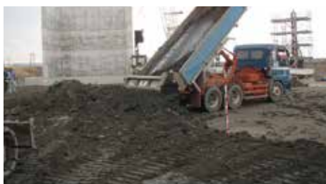
④ 養生後、再利用場所に運搬
