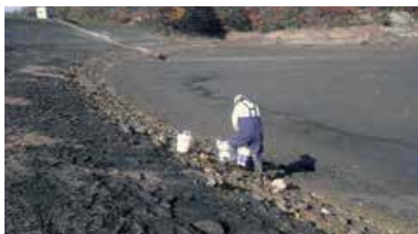
① 着工前サンプリング状況
