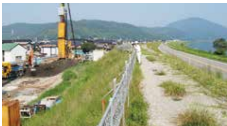
① 現場全景
