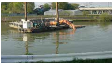
② 掘削状況
