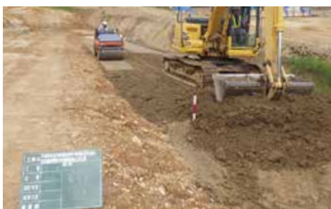
⑤ 所定期間養生後、敷均し・転圧
