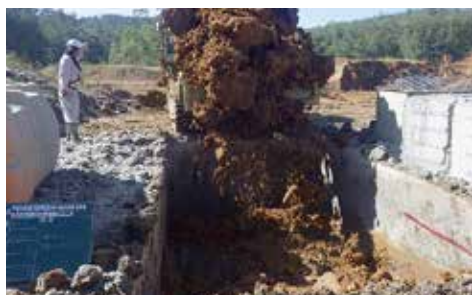
① 攪拌ピットに泥土投入
