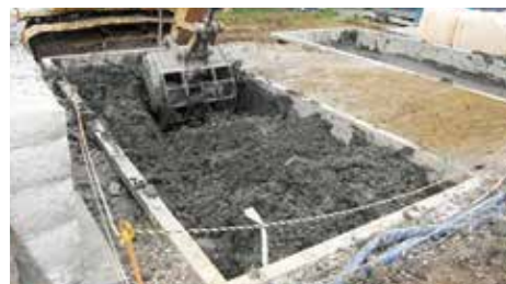
③ 改良状況
