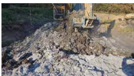
⑤ 原位置攪拌状況
