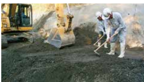
④ 改良土敷均し
