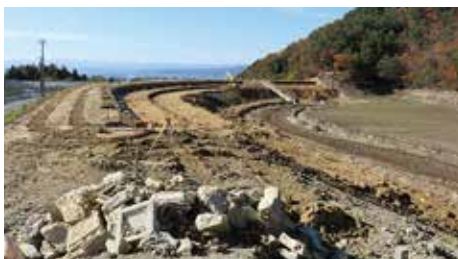
② 既設堤体段切り状況
