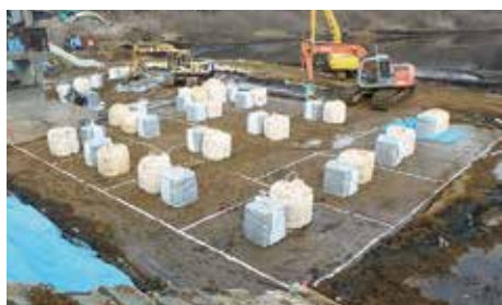
原位置攪拌、材料配置状況
