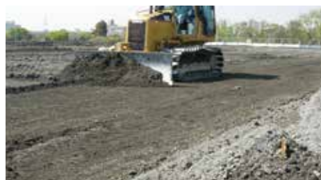
⑥ 敷均し・転圧状況
