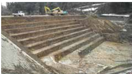
② 既設堤体段切り状況
