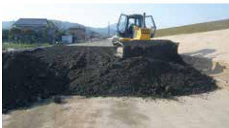
④ 改良土敷均し
