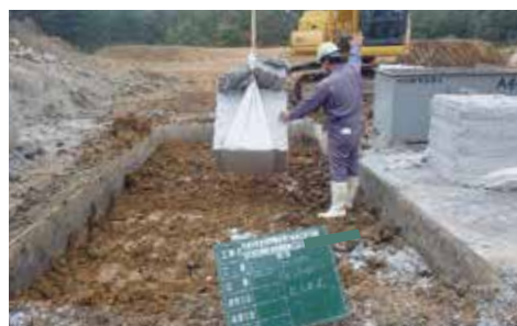
⑥ 現場投入状況
