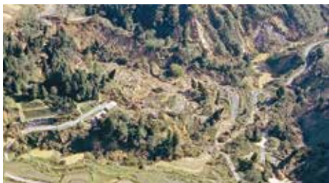
① 地すべり被災状況
