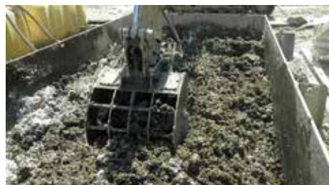
③ 改良状況
